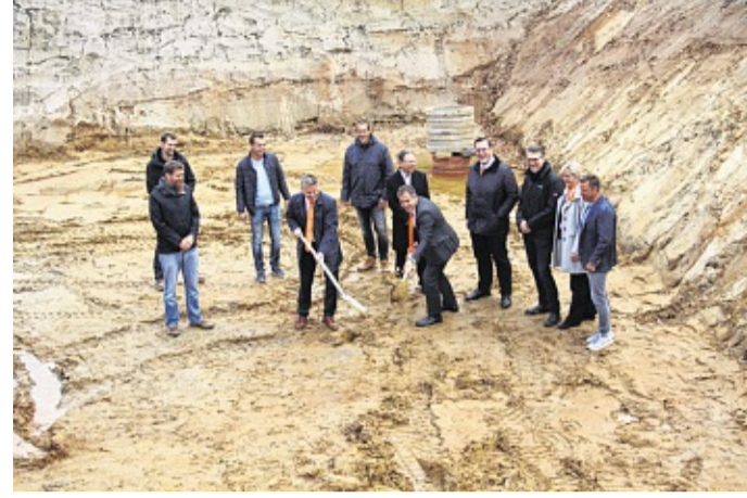
Guido Bloch und Daniel Horn erweitern im Beisein der weiteren Gäste die Baugrube.
